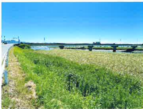
緑川下流に向かって『平木橋』を望む
